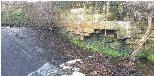
Bild 9: Abbruchsteine linke Wehrwange und Sohlschwelle aus Beton
